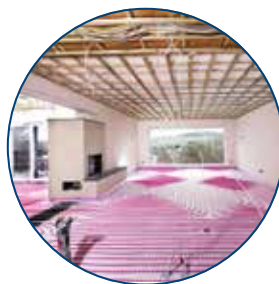
Vollflächige Verlegung der Klettplatten/-rohre gemäß Raumgeometrie
