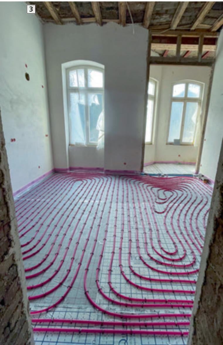
3 Im Erdgeschoss wurde im Zuge der energetischen Sanierung dagegen auf ein klassisches Nasssystem in Tackerbauweise gesetzt.
