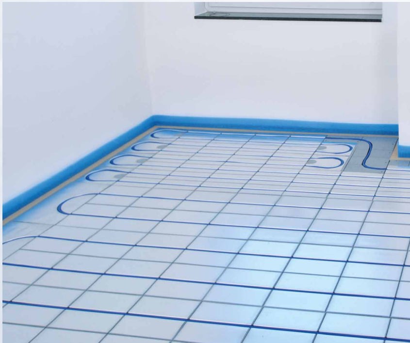
Fertig verlegte Fläche EQ POR Klimamodul – Bis zur Verlegung der Lastverteilschicht oder des Oberbodens Laufwege, z. B. mit Dämmplatten, vor Stauchung schützen. Es kann direkt weitergearbeitet werden.
