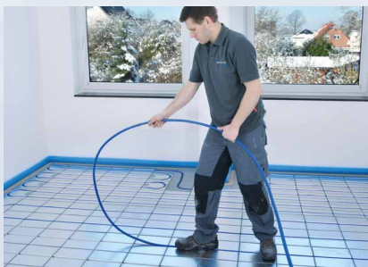
Systemrohr in einem großen Bogen von oben spannungsfrei in die Rillen drücken.
