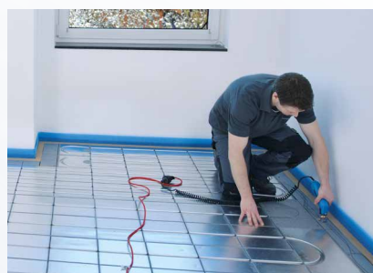
Mit dem Heißschneider individuelle Rohrführungen ausschneiden. Lange Rohrführungen in Wellenlinien ausschneiden.
