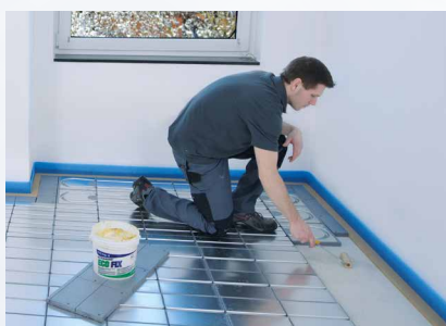
Bei Konstruktionen mit Strongboard müssen alle Elemente vollflächig mit RollFix-Kleber fixiert werden.
