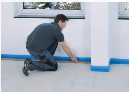
Randdämmstreifen auslegen und Rahmenhölzer auf sauberen, tragfähigen Untergrund verlegen.
