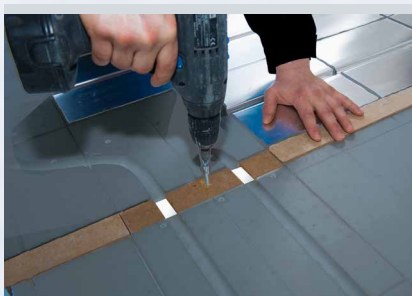
Im Türdurchgang das Rahmenholz wenn möglich im Untergrund verschrauben. Übergangsschienen lassen sich so später leicht anbringen.
