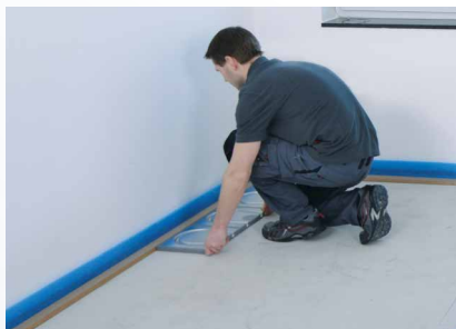
In einer Ecke mit Umlenkelement beginnen. Bündig zum Rahmenholz verlegen.
