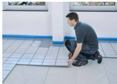
Mittelement vollflächig auslegen. Zur Vereinfachung der Montage können die Umlenkelemente mit z. B. RollFix fixiert werden.
